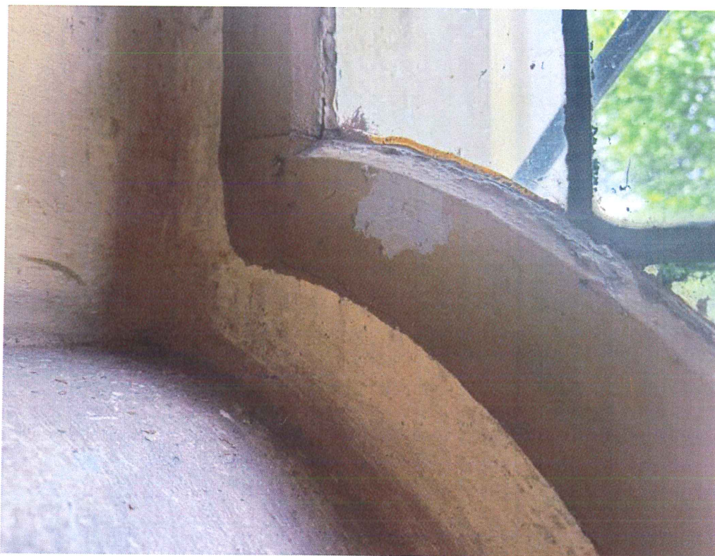
Kolor szary pod istniejącą warstwą farby olejnej (strona wewnętrzna).
