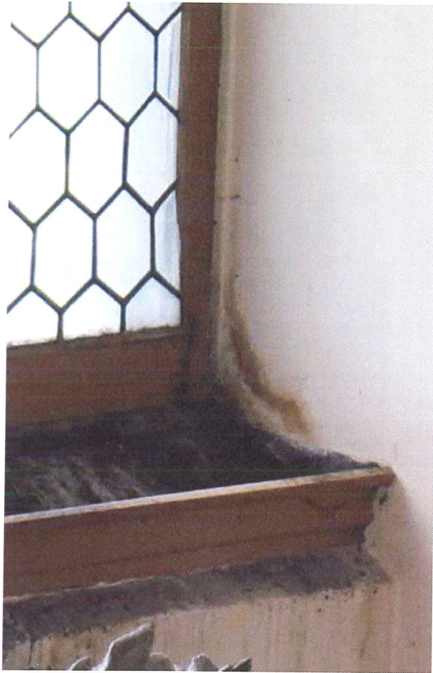
Widoczne wybrzuszenie witraża (strona wewnętrzna)
