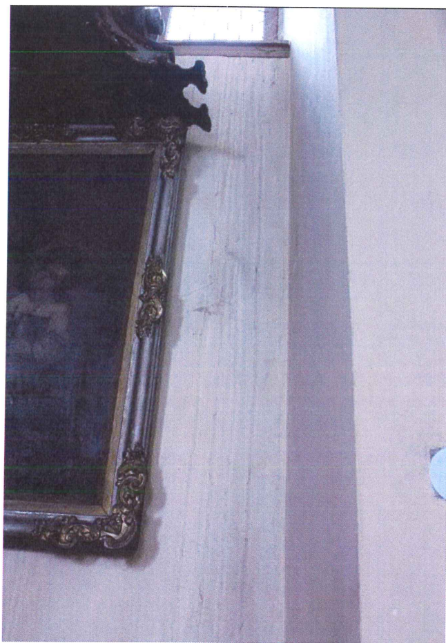
Zacieki na ścianach od wewnątrz wynikające z nieszczelności okien
