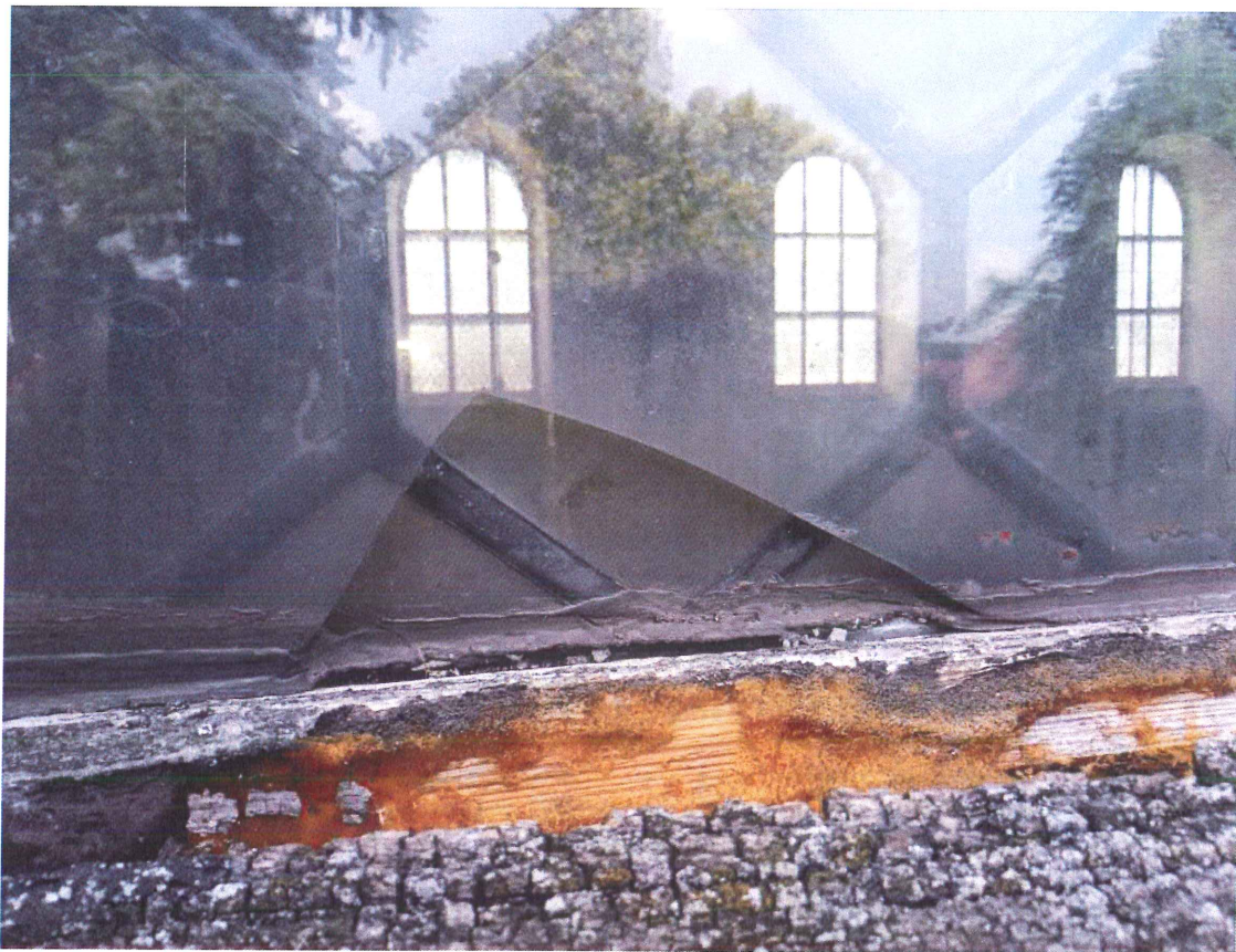
Pęknięcia szkła zabezpieczającego
