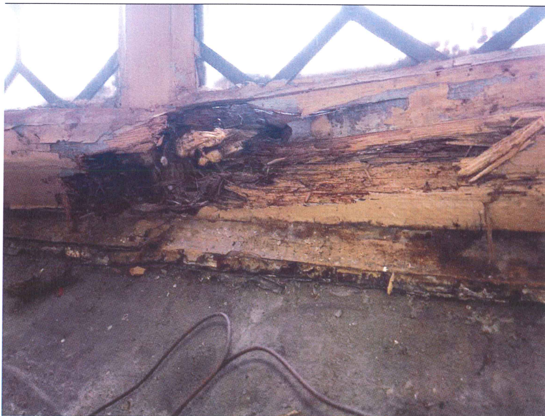
Zniszczenie ramy okiennej od wewnątrz
